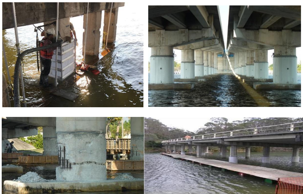
Figura 6 – Instalação de anodos galvashield DAS com o auxílio de jaquetas durante os serviços de reabilitação de estacas de concreto no mar.
