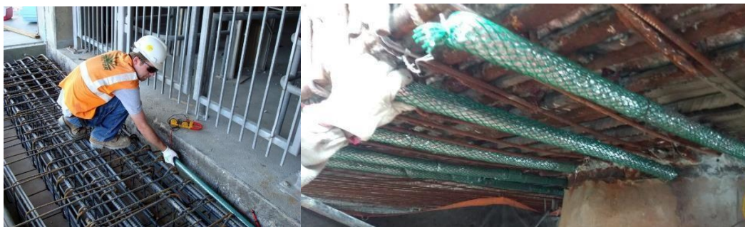
Figura 5 – Instalação de Anodos Galvashield DAS (peças verdes), durante os serviços de reabilitação de estruturas de concreto contaminadas por cloretos.
