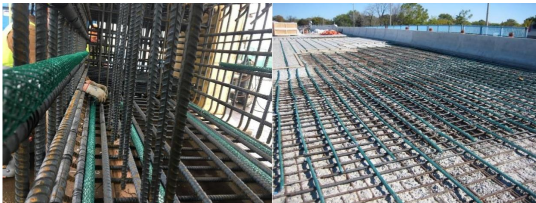
Figura 4 – Instalação de anodos galvashield DAS (peças verdes) durante a construção de obras novas
