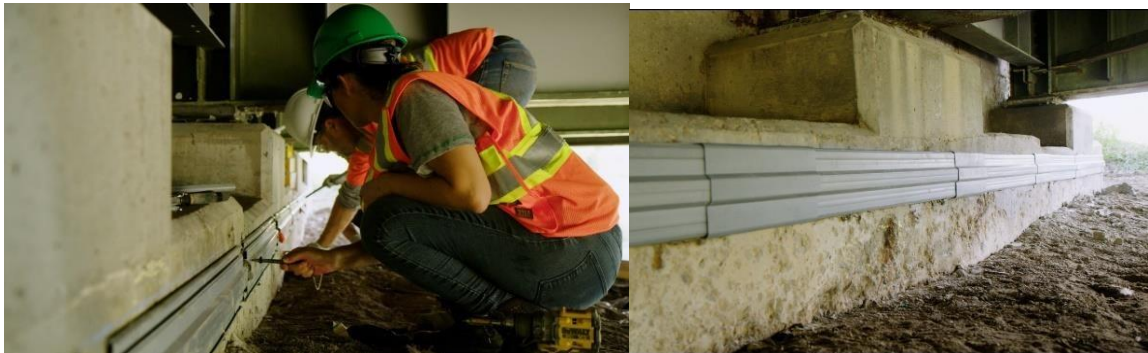
Figura 9 – Instalação dos anodos galvashield SM-DAS
