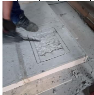
Figura 10 – Demolição da área para aplicação do reparo.
