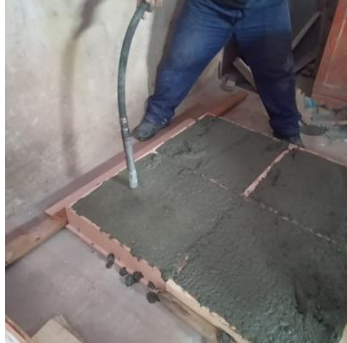
Figura 7 – Concretagem das placas de concreto.
