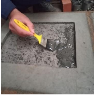
Figura 12 – Aplicação de ponte de aderência com adesivo epóxi fluido.
