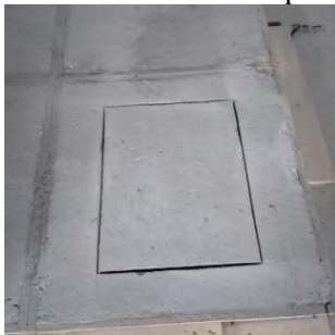
Figura 9 – Corte para delimitação da área de reparo
