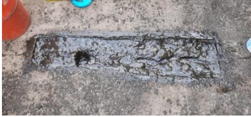
Figura 5 – Aplicação de ponte de aderência com adesivo epóxi fluido.
