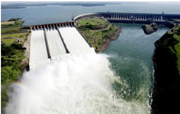
Figura 1 – Vertedouro da UH Itaipu, com as três calhas em operação: Direita, central e esquerda.
