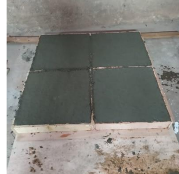
Figura 8 – Placas após a concretagem.
