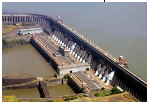
Figura 3 – Barragem de concreto e a casa de força da Usina Hidrelétrica de Itaipu.
