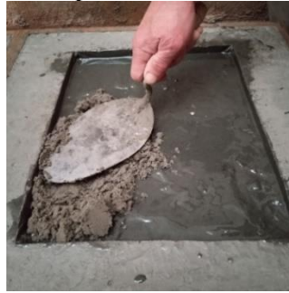
Figura 13 – Aplicação de material de reparo em área com ponte de aderência.
