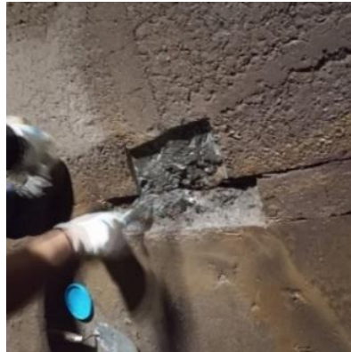
Figura 4 – Aplicação do adesivo estrutural fluido à base de resina epóxi como ponte de aderência.
