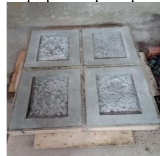
Figura 11 – Áreas de reparo preparadas para aplicação
